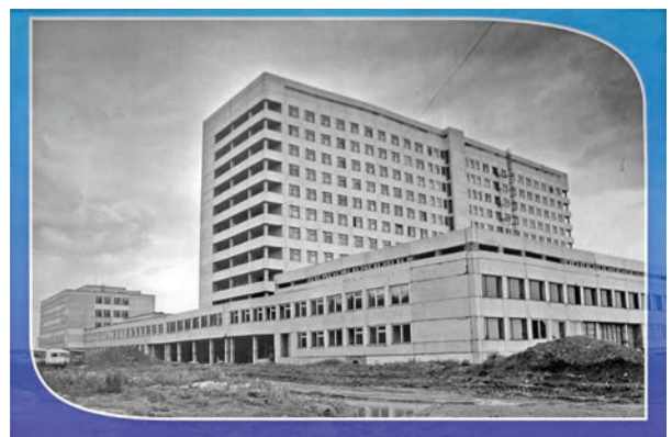
Здание ККЦ на этапе строительства
